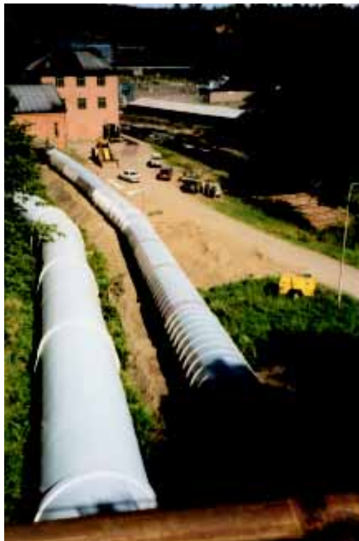
Nytt vattenledningsrör till Ludvika kraftstation. Tillverkat i NM Lamineringsepoxi
